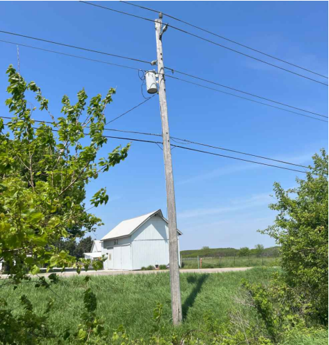
4 EXISTING POWER POLE/ TRANSFORMER SCALE: N.T.S.
